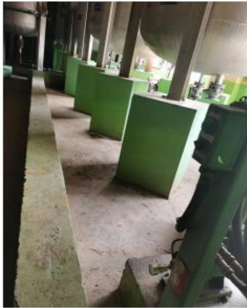
浸胶车间罐区防渗效果
